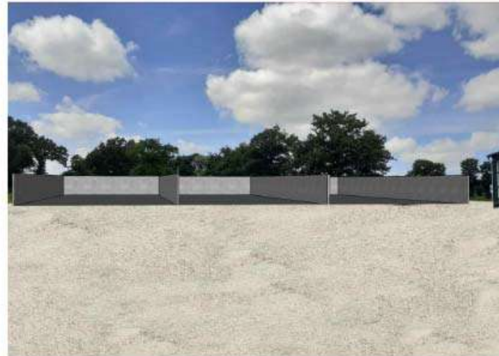
Silos de stockage
